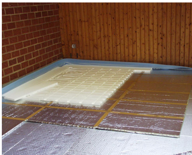
Abbildung 29: Einbau der VIPs in den Fußboden. Zu sehen: PU-Platten im Vordergrund, VIPs mit abgeklebten Fugen und EPS-Platten mit Aussparung für die Heizschlangen.
