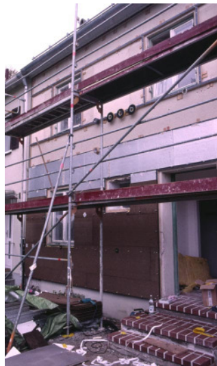
Abbildung 16: Einbau der VIPs in die Nordfassade.
