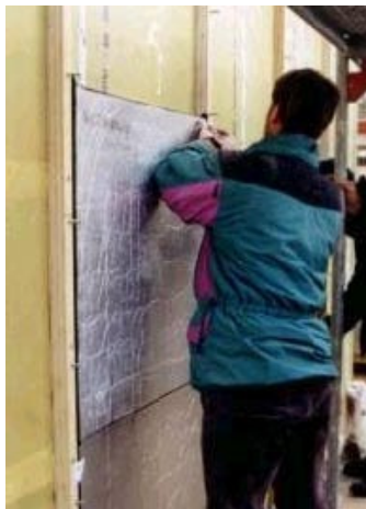
Abbildung 8: Einbau der VIPs in die Holzlattungskonstruktion.
