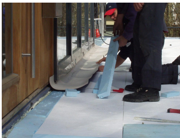
Abbildung 38: Einbringen der EPS-ummantelten VIPs zur Dämmung des unterkellerten Außenbereiches.
