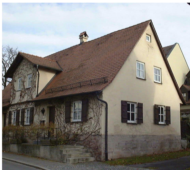
Abbildung 1: Ansicht der zu sanierenden Giebelfassade mit geringem Dachüberstand.
