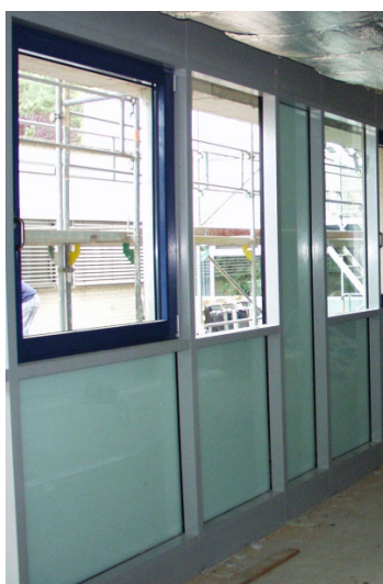
Abbildung 26: Innenansicht der vakuumgedämmten Pfosten-Riegel-Fassade.
