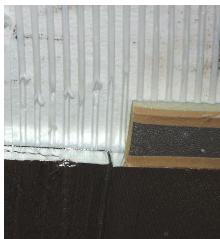
Abbildung 32: Aufbringung der VIPs mittels Dispersionskleber auf die EPS-Platten.
