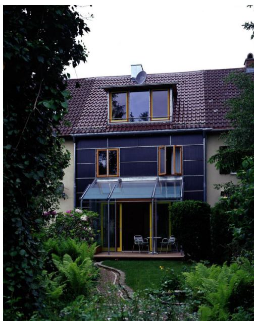
Abbildung 19: Ansicht der sanierten Südseite mit den schwarzen Fassadenkollektoren.
