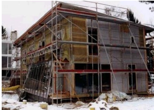
Abbildung 9: Ansicht Ostfassade während des Einbaus der VIPs.
