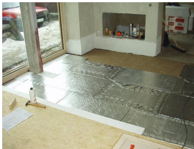
Abbildung 36: Einbau der VIPs in die Fußbodendämmung im Kellergeschoß.
