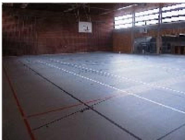
Abbildung 30: fertiggestellte Turnhalle mit teilweise vakuumgedämmtem Fußboden.
