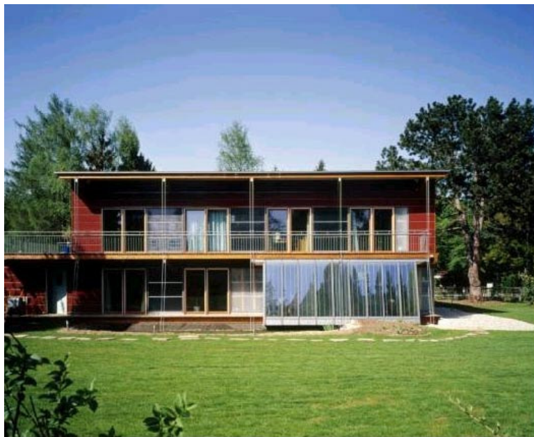
Abbildung 10: Südsansicht des fertiggestellten Neubaus.
