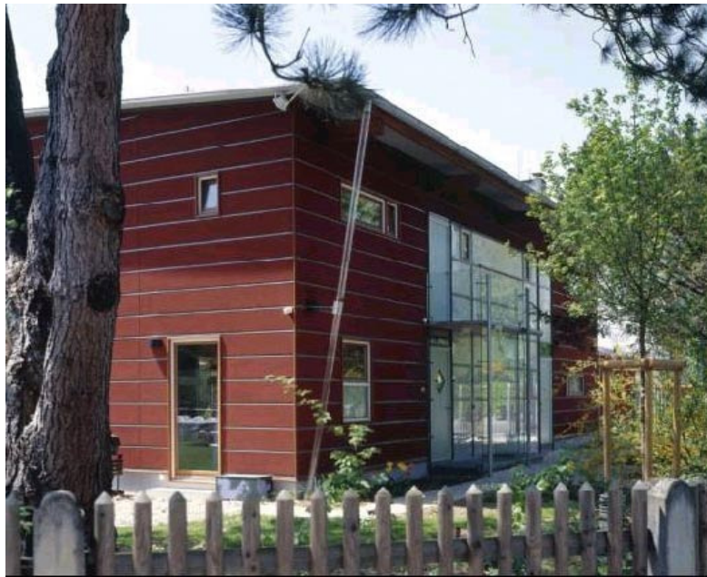
Abbildung 11: Nord-Ost-Ansicht der fertiggestellten Neubaus.
