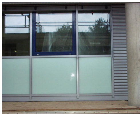
Abbildung 25: Außenansicht der vakuumgedämmten Pfosten-Riegel-Fassade.
