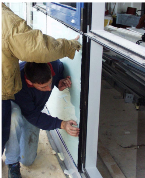
Abbildung 23: Einbau der Brüstungselemente in die Pfosten-Riegel-Fassade.
