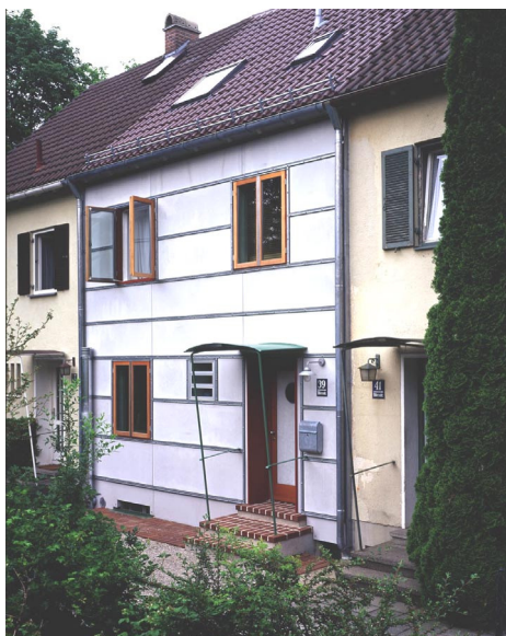
Abbildung 18: Ansicht der sanierten Nordfassade.
