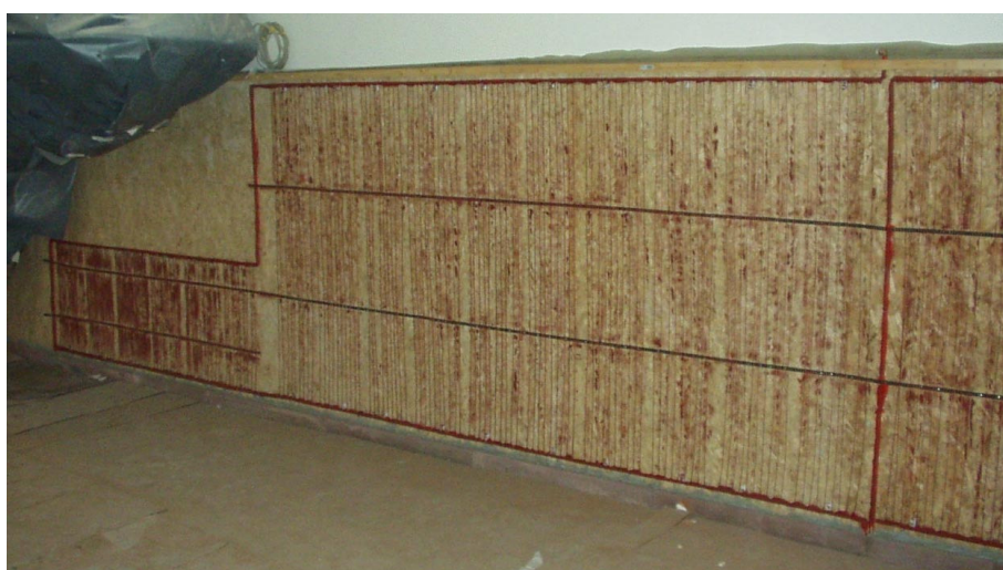
Abbildung 34: Vakuumgedämmtes Wandheizungssystem mit an OSB-Platten befestigten Kupferheizschlangen.
