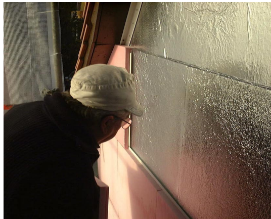
Abbildung 3: Installation des VIP-WDVS bei der Sanierung der Giebelfassade.
