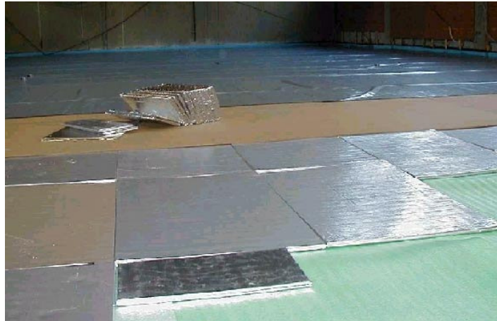
Abbildung 41: Einbringen der Dämmung in die Turnhalle. Zu sehen: Schaumfolie (grün), VIP, Holzweichfaserplatten (braun) und aufliegend die PE-Dichtfolie.
