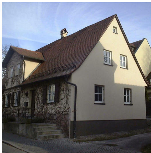
Abbildung 4: Ansicht der mit dem VIP-WDVS sanierten Giebelfassade.
