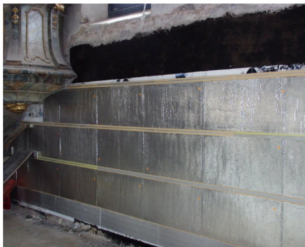
Abbildung 33: Installation des Wandheizungssystems nach Anbringen der VIPs.
