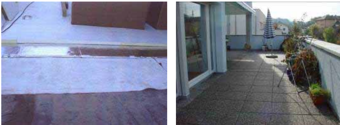
Abbildung 27: Baustelle und fertiggestellte Terrasse. Die VIP werden bereits während des Einbaus gut geschützt.
