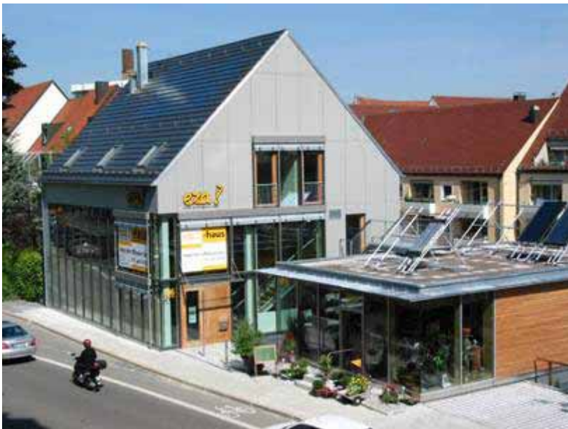
Abbildung 51: Aussenansicht des eza!-Hauses. (Foto: may.schurr.architekten, Bad Wörishofen)
