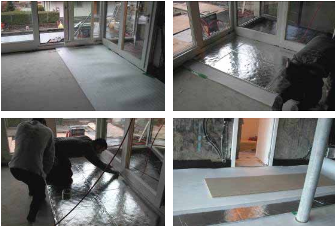
Abbildung 20: Aufbau des Bodens mit VIP.
