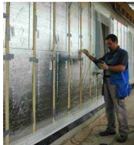
Abbildung 50 links: Anblick der fertig gestellten und verputzten Fassade. rechts: Montage der Putzträgerplatten aus Polyurethanschaum an Balkondecke und Test des Gasdruckes der installierten Vakuumdämmplatten mit dem tragbaren "va-Q-check"-System.
