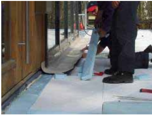
Abbildung 52 links: Einbau der EPS-ummantelten VIP. Der Randstreifen zum angrenzenden Gebäude wurde mit Polystyrol-Passstücken aufgefüllt. (Foto: may.schurr.architekten, Bad Wörishofen) rechts: Aufbau der Bodendämmung im Aussenbereich.
