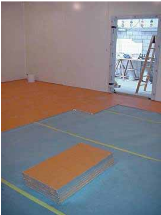
Abbildung 28: Baustelle der Bodendämmung im Kühlraum.
