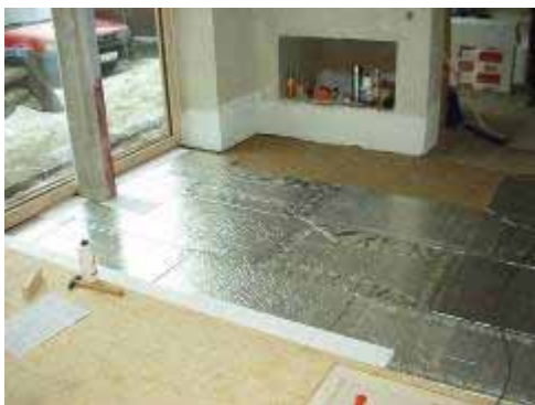
Abbildung 53 links: Einbau der VIP in die Fussbodendämmung. Im Hintergrund sind die Weichfaserplatten und im Vordergrund die OSB-Platten zu sehen. (Foto: may.schurr.architekten, Bad Wörishofen) rechts: Schichtaufbau des vakuumgedämmten Kellerbodens.
