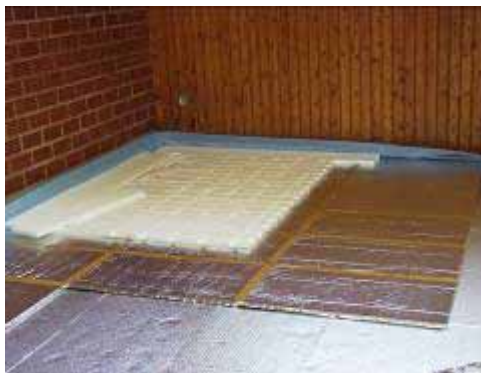
Abbildung 55 links: Fotografie des Fussbodens während des Einbaus. Zu sehen sind die silbrig glänzenden VIP auf dem mattsilbrigen, aluminiumkaschierten PU-Schaum. Darauf liegen die weissen Polystyrolplatten mit den Vertiefungen für die Heizschleifen. rechts: Querschnitt durch den Fussbodenaufbau sowohl mit als auch ohne Vakuumdämmung.
