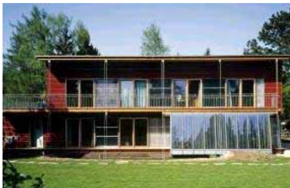
Abbildung 39 links: Südansicht, zwischen den Fenstertüren sind Fassadenkollektoren integriert. rechts: Querschnitt durch den nördlichen Wandaufbau.
