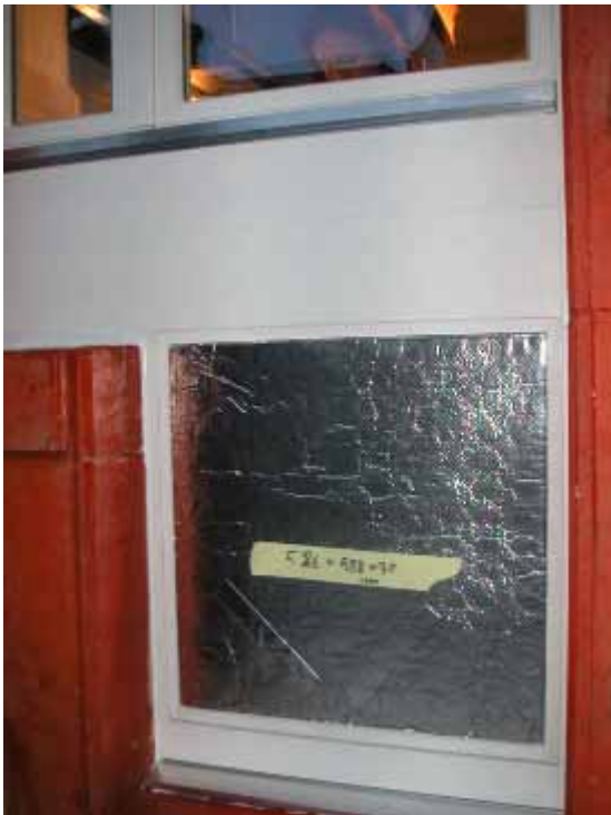
Abbildung 34: Fensterelement mit eingepasstem VIP.
