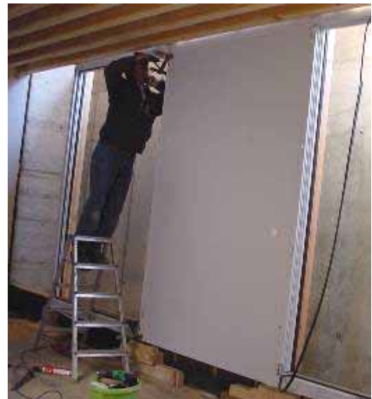
Abbildung 36 links: Ansicht der Reihenhausbauweise und Horizontalschnitt durch die Konstruktion. rechts: Installation eines Vakuumdämmelements.
