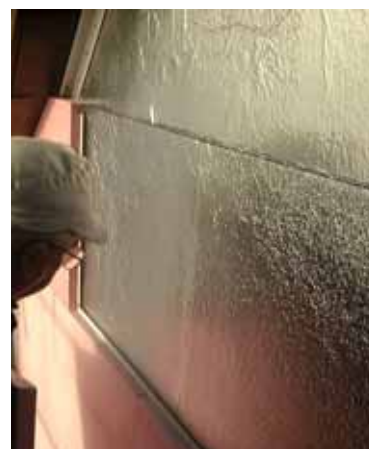
Abbildung 38 links: Querschnitt durch den Wandaufbau. rechts: Giebelwand beim Einbau. Die VIP sind bereits in das Schienensystem eingefügt. Die Polystyrolplatten werden gerade aufgebracht.
