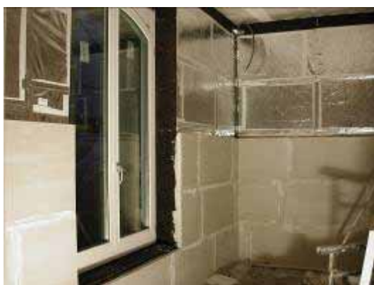
Abbildung 23 links: VIP-Innendämmung mit teilweise erstellten Gipswand. rechts: Fertige Lukarne.
