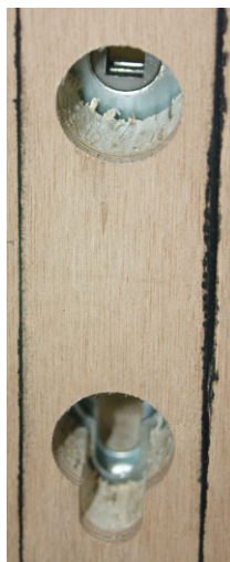
Bild 7. Ansicht des Schloßbereiches nach Demontage des Schloßschildes Fig. 7. Cylindrical hole left free for the pin in the door leaf cover after removing the doorplate
