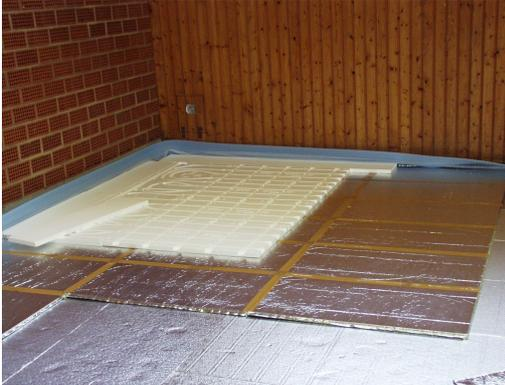
**Art der Dämmung: Sanierung mit Dämmung unter einer Fußbodenheizung**
