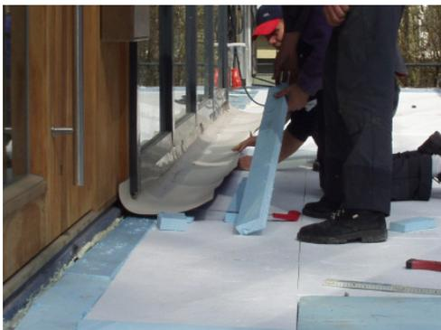
**Art der Dämmung: Fußbodensanierung mit Vakuumdämmung im Außenbereich**
