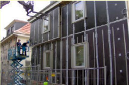
**Positionierung VIP-gedämmter Elemente vor der gehwegbündigen Altfassade**
