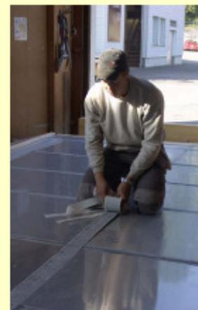
VIP's mit Dämmkante für fugendicht Verlegung
