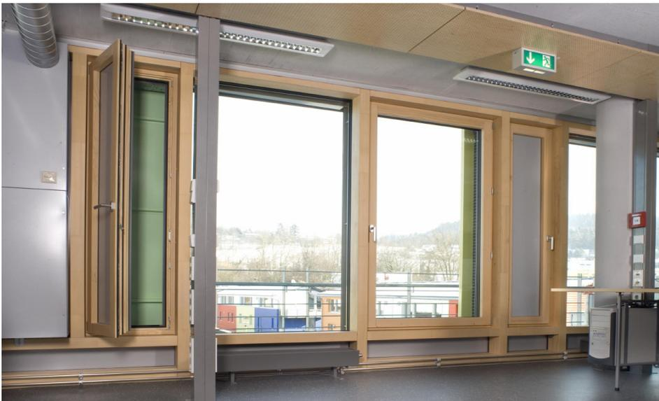
*Einsatz von dreifachverglasten Fenstern und VIP im Sonnenschiff*
