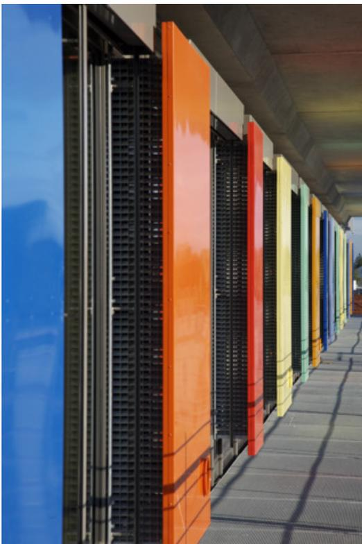
*Verblendungen der Lüftungklappen*
