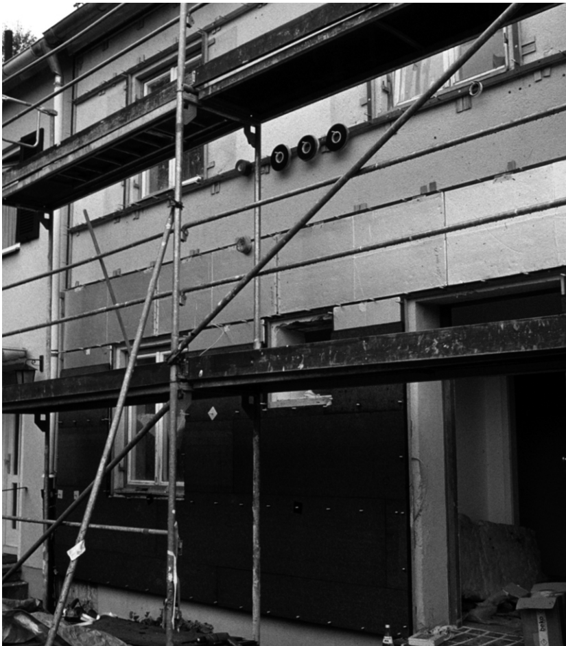
Bild 14: Fassade Nord im Bau
