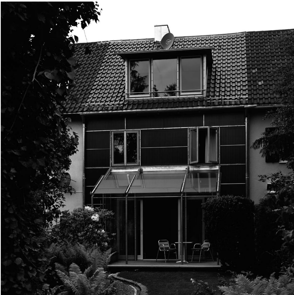
Bild 16: Ansicht Süd neu mit Fassadenkollektor
