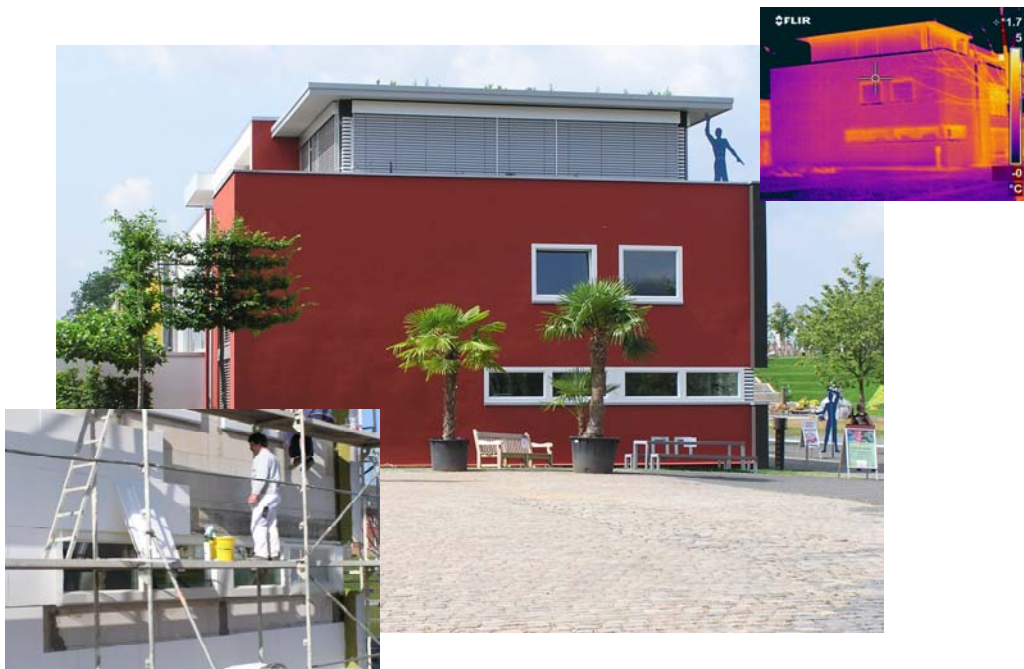
Abb.: 11) Passivhaus Petrisberg/Trier mit beidseitig EPS kaschierte VIP's
