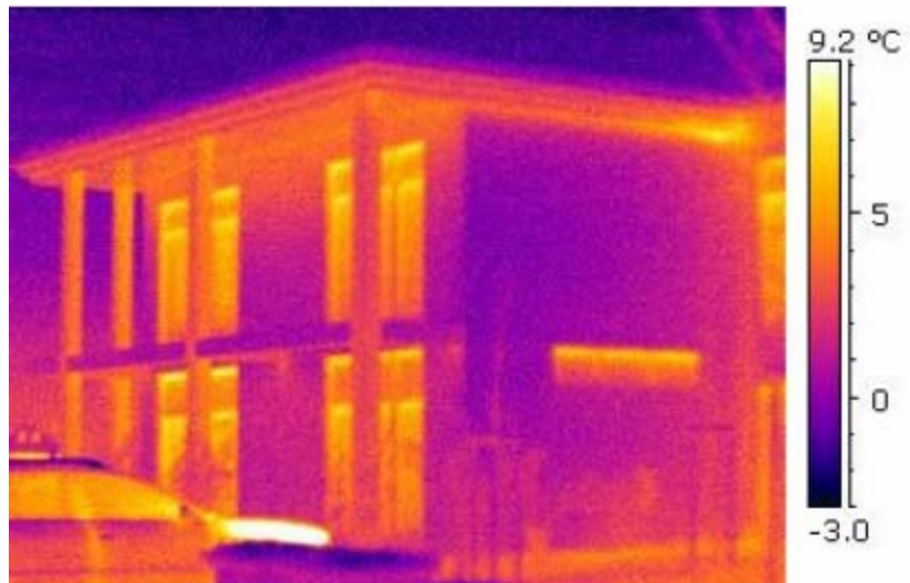
Abb.: 8) Thermografie des Passivhauses Bersenbrück
