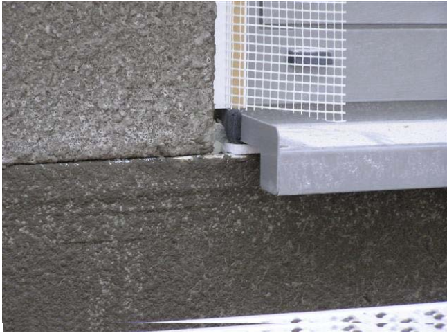
Abb.: 14) Anschluss mit VIP an ein Fenster.
