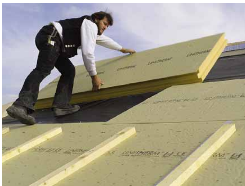
Bild 2: Verlegung von LINITHERM PAL N+F
