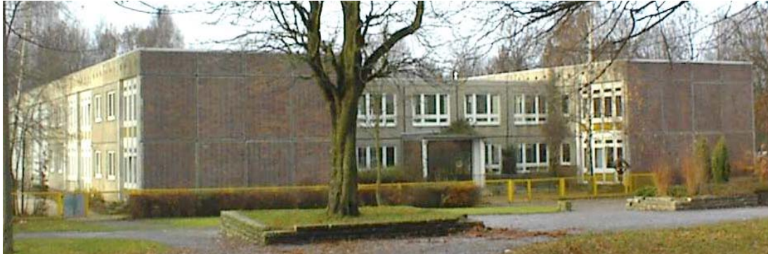
Bild 1: Ostfassade der Kita „Plappersnut“ vor der Sanierung to: IGEL Institut für Gebäude+Energie+Licht Planung)
