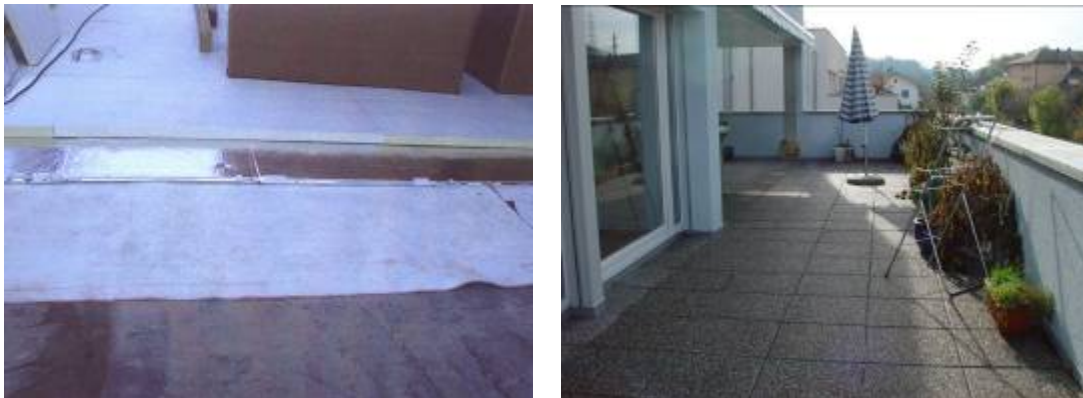
Bild 9: Ausführung – Fertige Terrasse: Die Paneele sind während des Einbaus gut geschützt.
