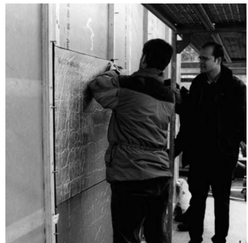
Bild 6: VIP zwischen Riegelwerk
