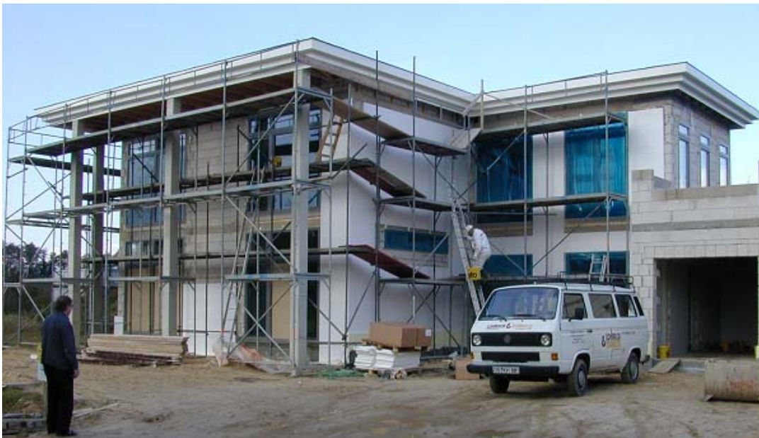
Abb.: 9) Passivhaus Bersenbrück mit in 2 cm EPS eingeschäumten VIP-Elementen
