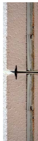
Abb.: 4) Integration von VIP in ein mechanisch befestigtes WDVS
