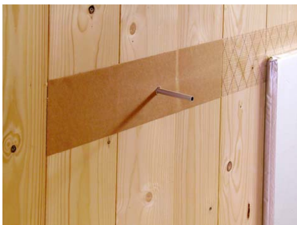
Bild 01 Holzweichfasertafel mit luftdichter Ebene
