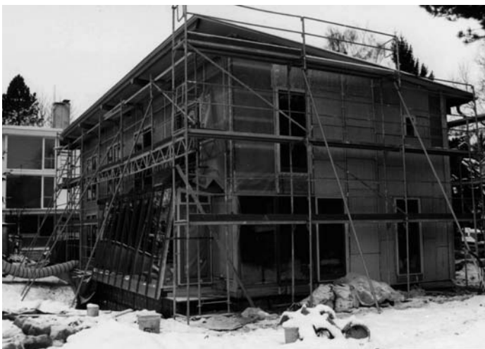
Bild 5: Baustelle von Ost, VIP
