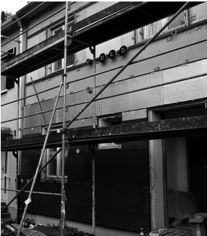
Bild 14: Fassade Nord im Bau
