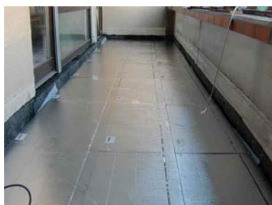
Verlegte VIP, Terrassendämmung
