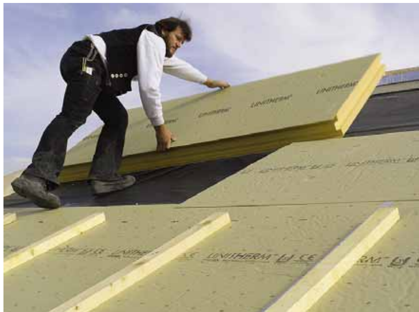
Bild 2: Verlegung von LINITHERM PAL N+F
