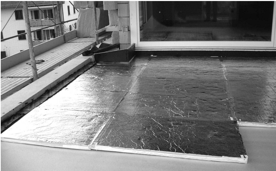
Bild 1: Dämmung einer Terrasse mit VIP. Als Schutzschichten werden beidseitig dünne konventionelle Dämmplatten oder Bautenschutzmatte eingesetzt.
