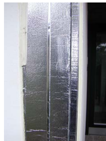
Außenecke VIP-Fassade Karlsruhe
