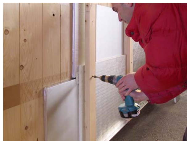
Bild 02 Aufbau der VIP-PUR Ebenen
