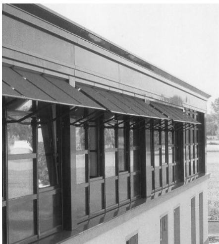
Bilder 10 a, b: tempsafe® elements als Fassadendämmelemente
