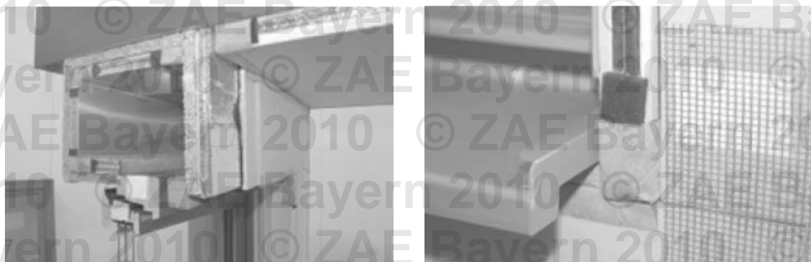
Rollladenkastendämmung und Detailanschluss Fensterlaibung mit VIP aus [26].
