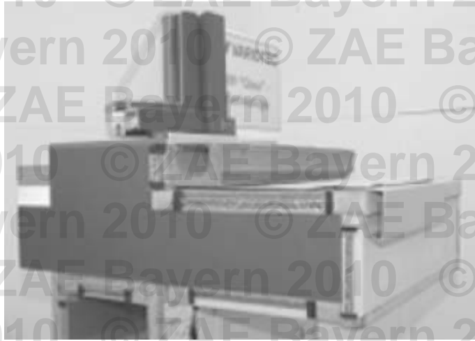
Fenstertür mit niveaugleichem Dachaustritt aus [26].
